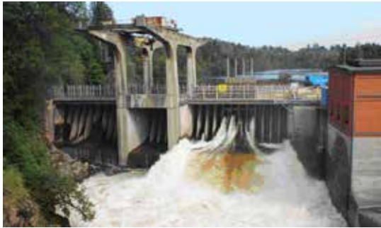
Vattenkraftverk. Foto: Anna Uller
