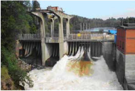
Vattenkraftverk vid Norsälven i Kil, foto: Anna Uller
